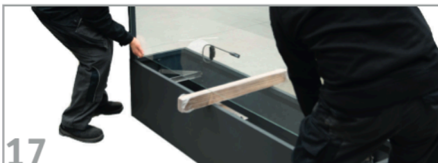
17 Glasscheibe einsetzen: Zu zweit die Glasscheibe auf die Glashalter setzen und ggf. mit einem Hilfsobjekt abstützen
