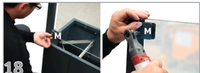
18 Glashalter-Gegenstücke anbringen: An den Glashaltern K und L jeweils die Gegenstücke M festschrauben
