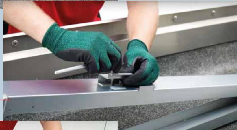
Bringen Sie die flexiblen Modulhalter zur Aufnahme des Solarpanels an.
