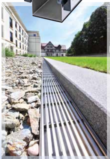
Auf voller Länge des Wohntraktes des Hotels wurden Ferro Magna Rinnen verbaut.
