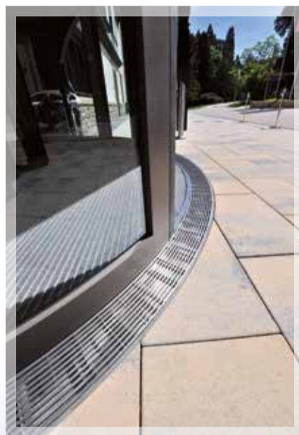
Die radialen Cubo Rinnen und Hydra Linearis Roste wurden an die Karusselltür des Haupteingangs maßgefertigt angepasst.
